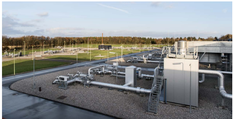
Røranlæg på kompressorstationen i Egtved
