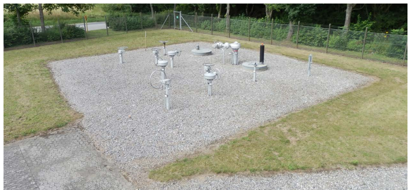
Eksempel på linjeventilstation
